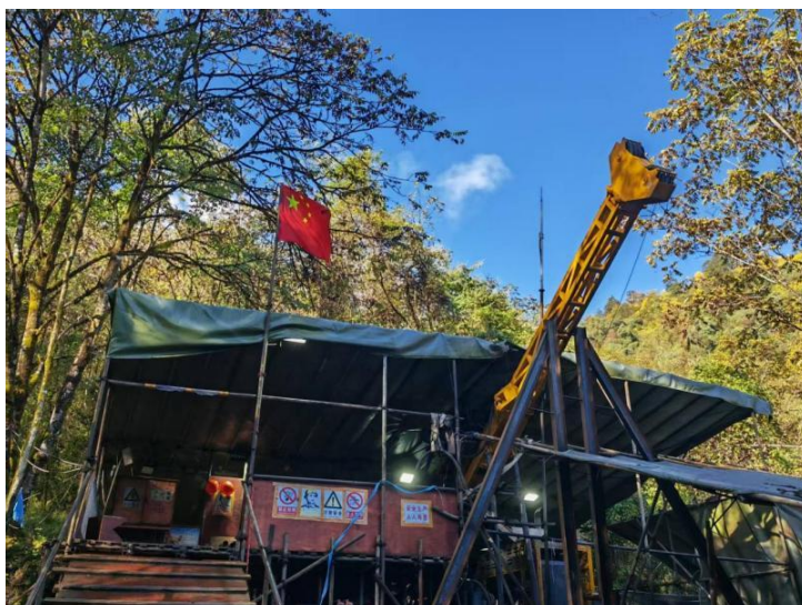
图 7.2-1 前期已批复的钻探点施工现场隔音帐篷图示
