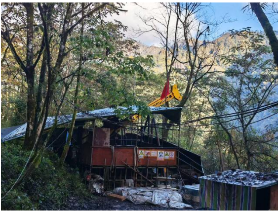
图 8.1-1 引大济岷前期钻探点钻探平台
