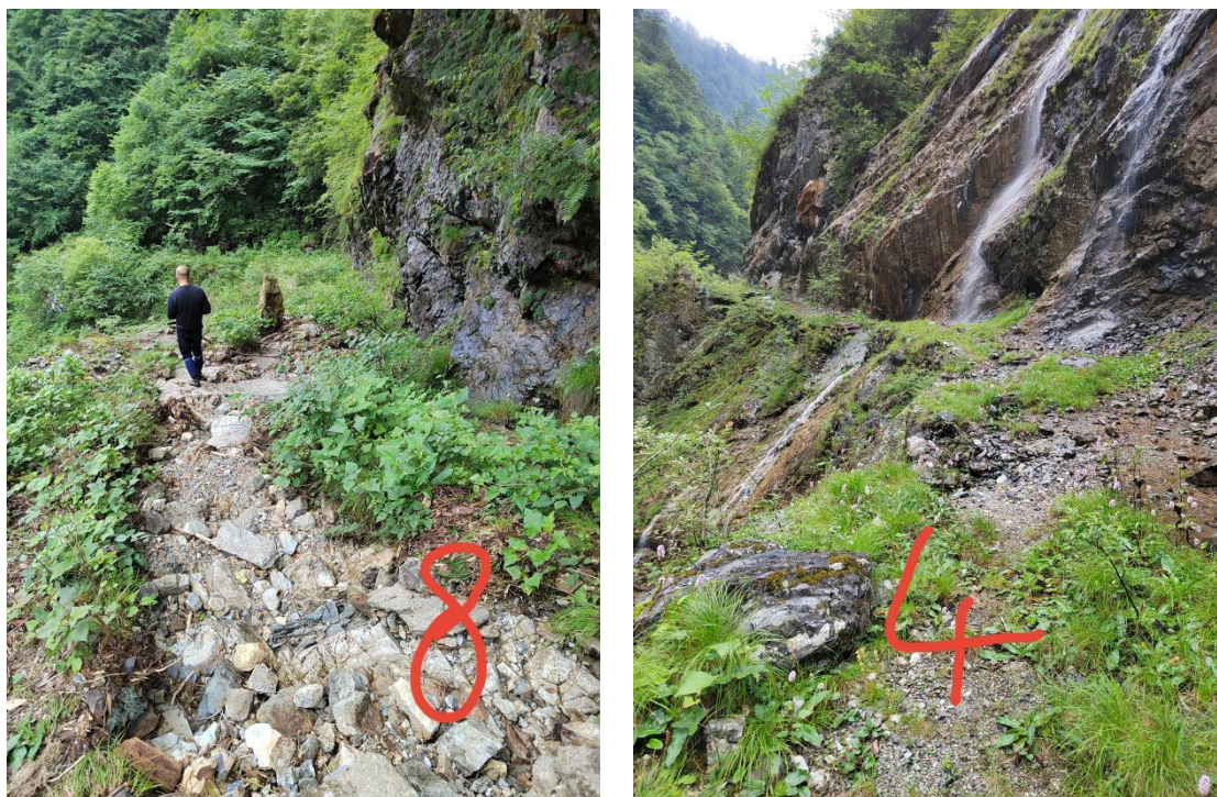
图 2.8-4 铅厂沟道路现状
