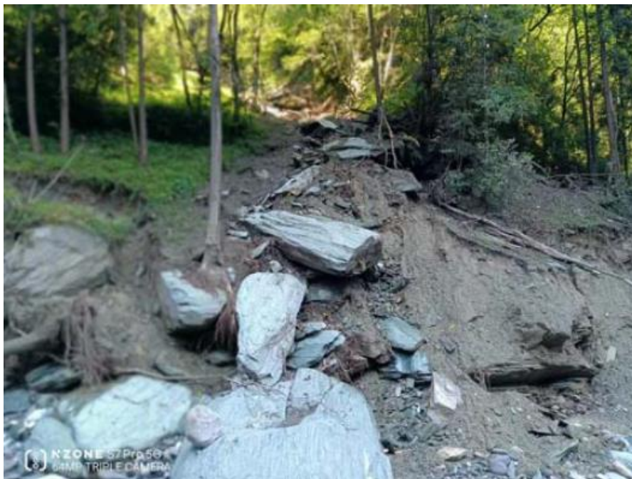
图 2.4-7 鸡公垭沟坡面切沟侵蚀物源现状
