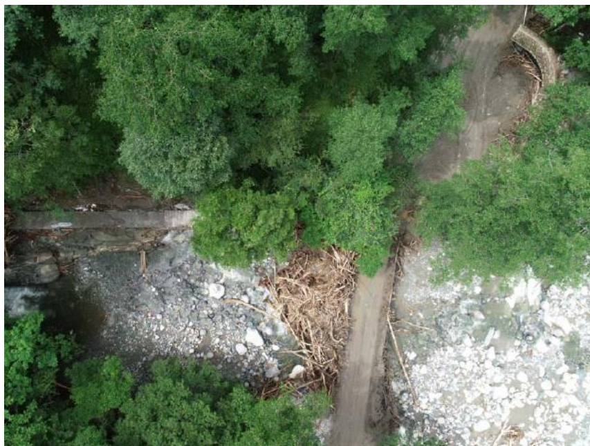
图 2.4-2 吴尔沟泥石流沟口地貌现状
