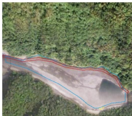
打索场段（施工后）
