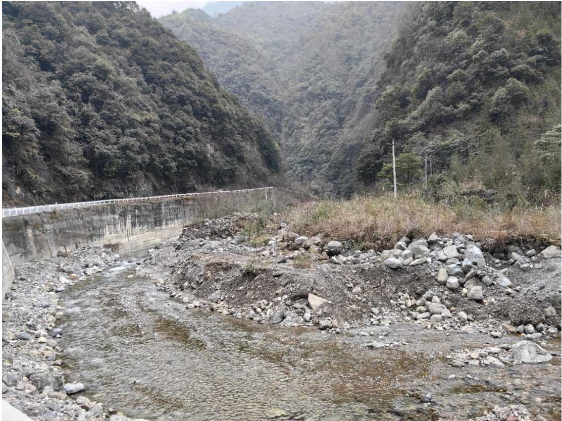
图 2.1-6 邳江河山水源段右侧河岸淤积照片（施工前）
