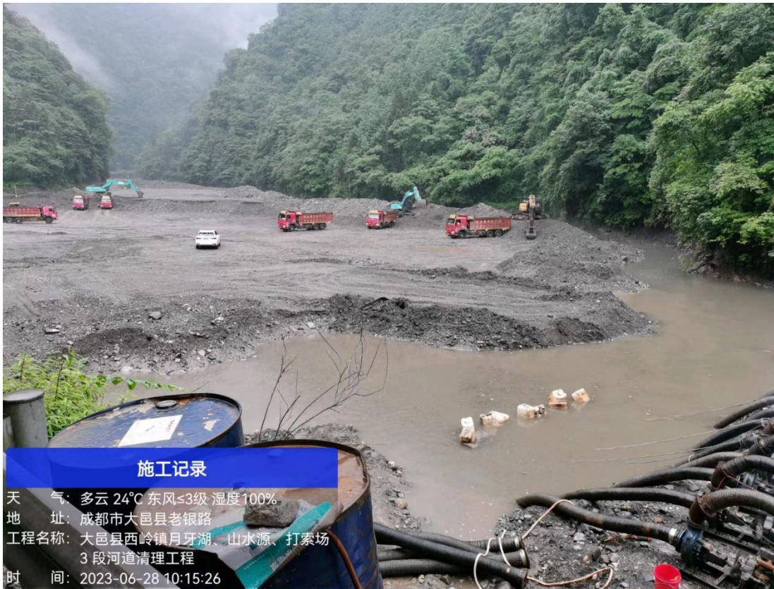
图 5.3-1 施工期间现场图片（拍摄于 2023 年 6 月）
