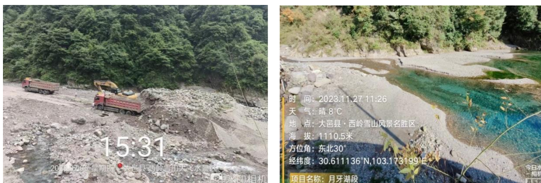
图 2.8-4 项目施工期及施工后照片
