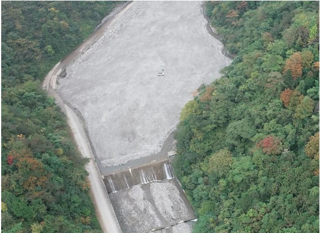
图 2.1-4 邛江河打索场段俯视照片（施工前）
