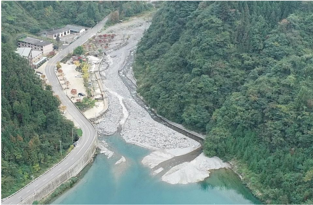
图 2.1-1 大飞水河月牙湖段河槽照片（施工前）
