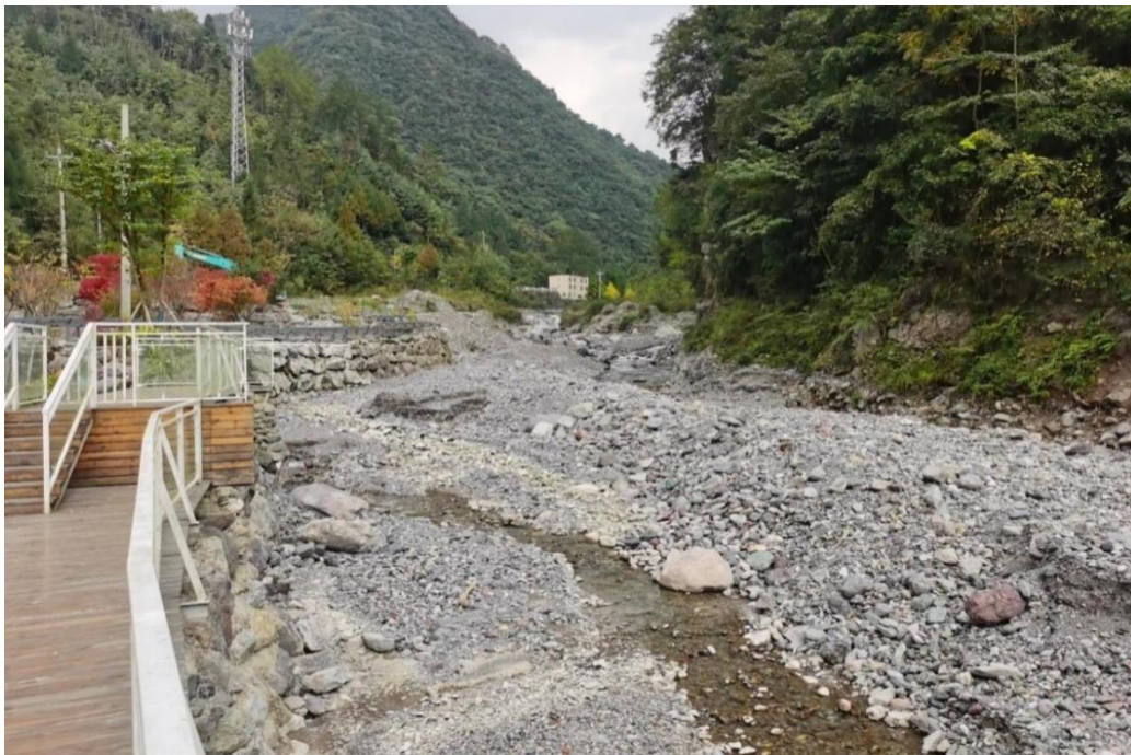
图 2.1-2 大飞水河河道主河槽淤积成心州（施工前）
