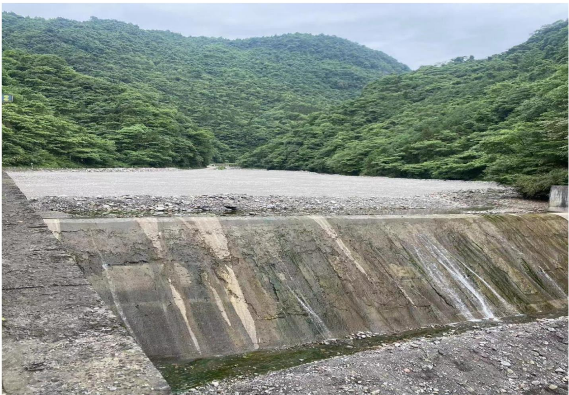
图 2.1-5 邛江河打索场拦河堰段库区淤积照片（施工前）
