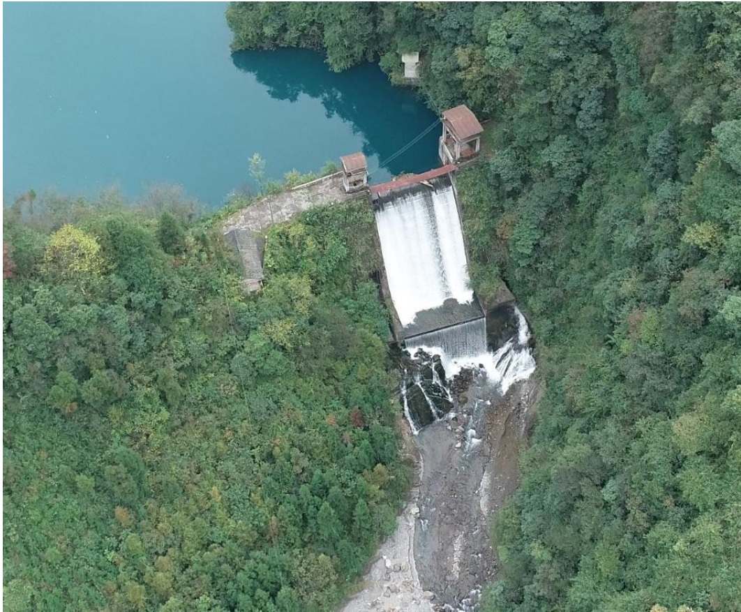
图 2.1-3 大飞水河月牙湖段春坪大坝（施工前）
