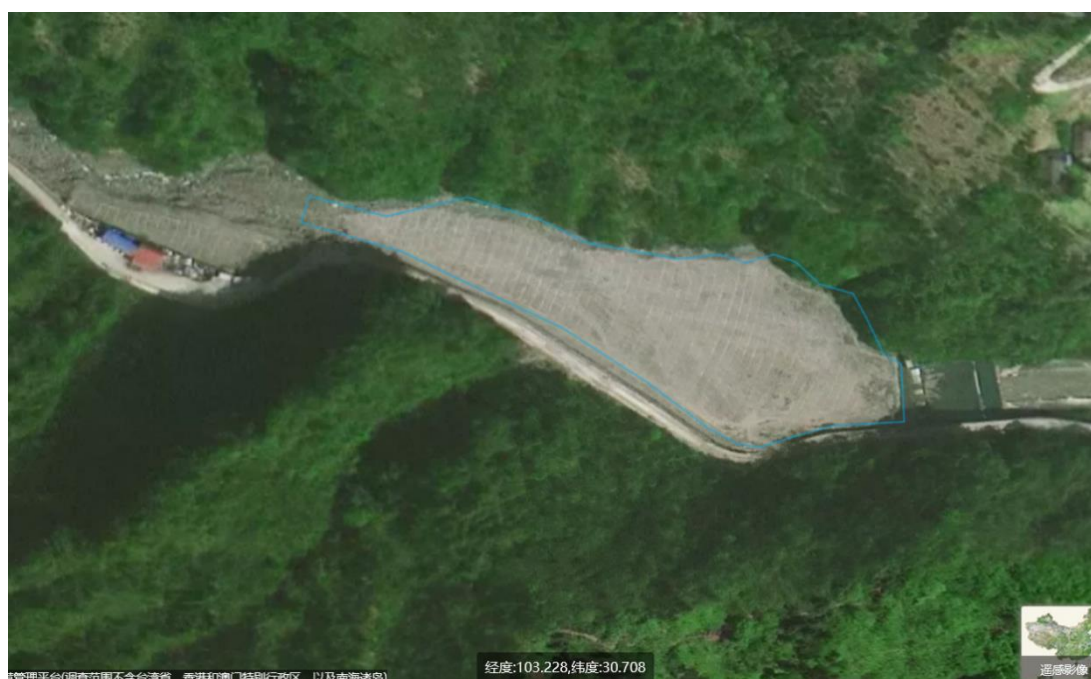
图 5.4-2 打索场段主体工程区（清障范围）临时占地历史影像图（施工前-2020 年、2022 年）
