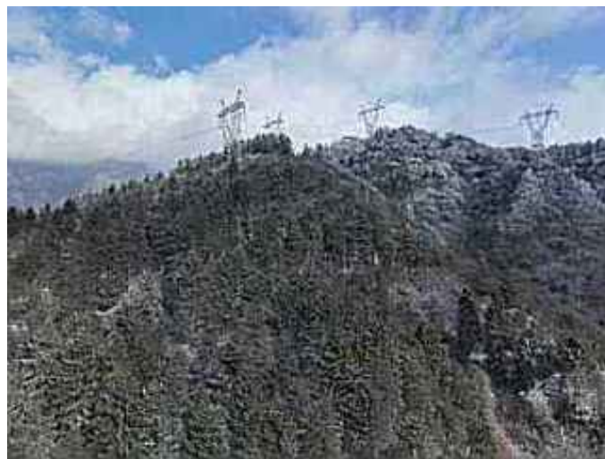
500KV 茂谭 I、II线
