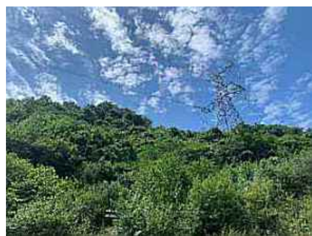
已有500kv塔基下方植被情况
