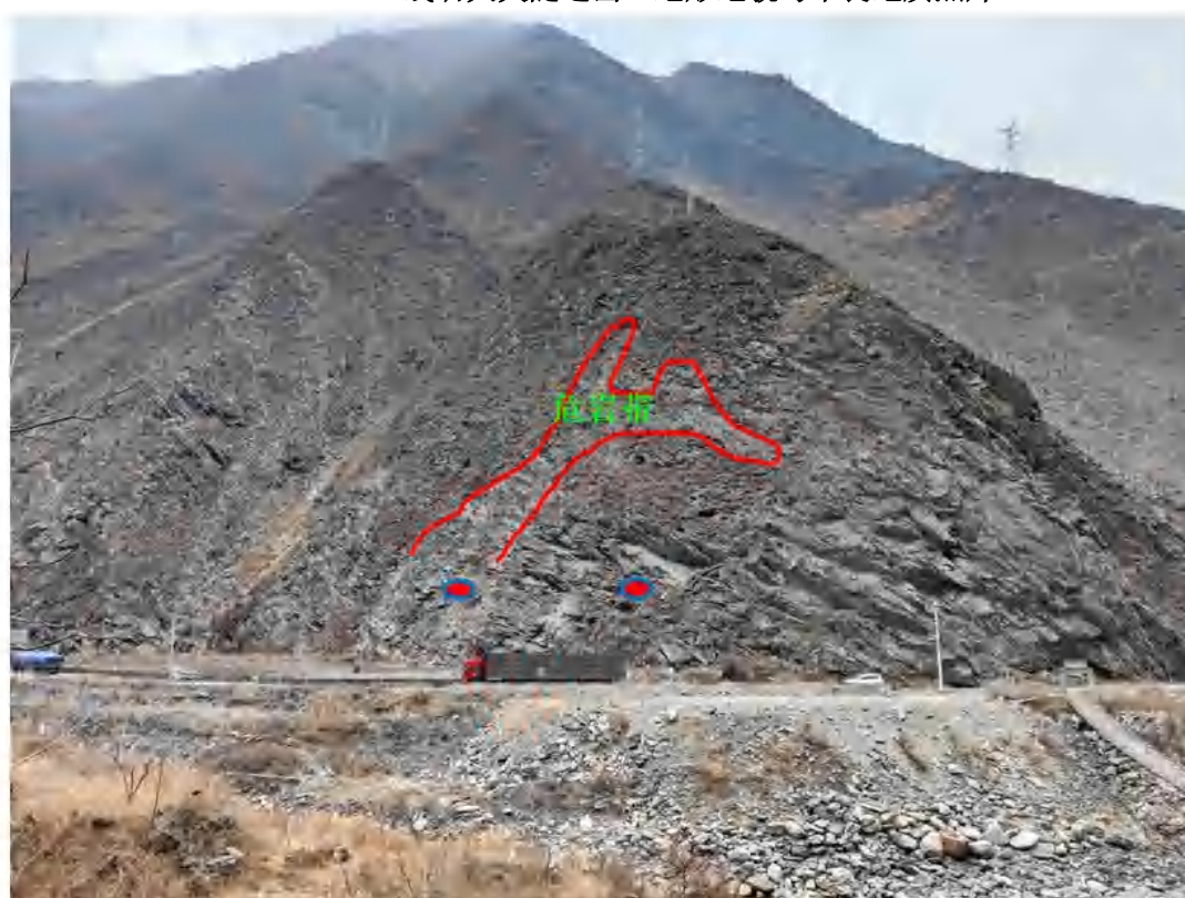
2.4-16 B 线沙坝隧道进口地形地貌与不良地质照片
