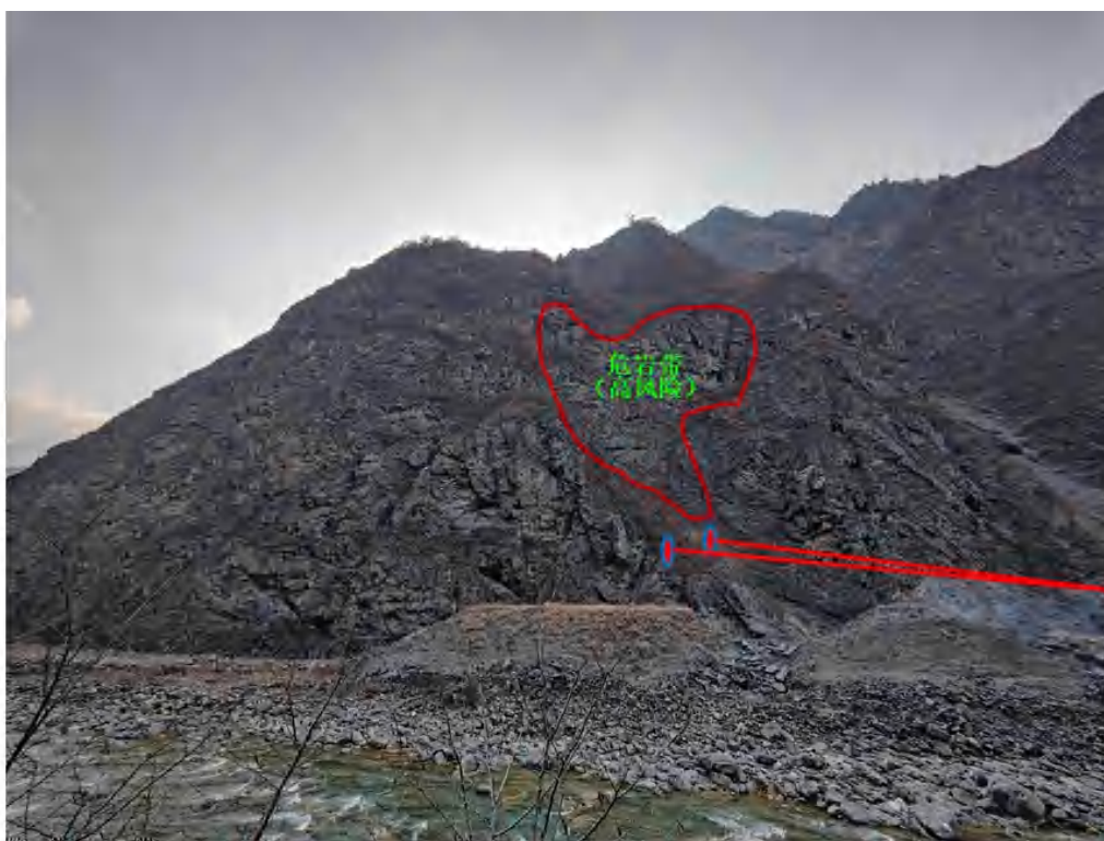
2.4-14 B 线石大关隧道进口地形地貌与不良地质照片
