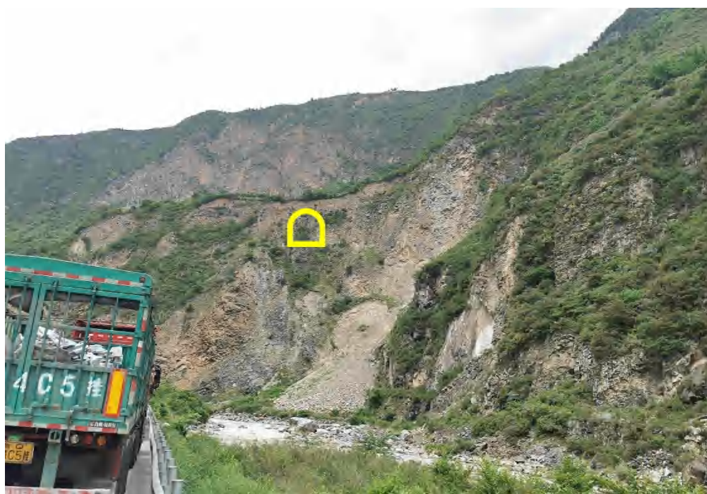
图 2.4-12 K 线隧道出口处地貌及地质
