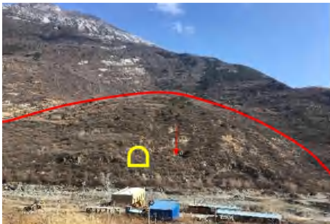
图 2.4-10 E 线木耳寨隧道出口滑坡及后部顺层
