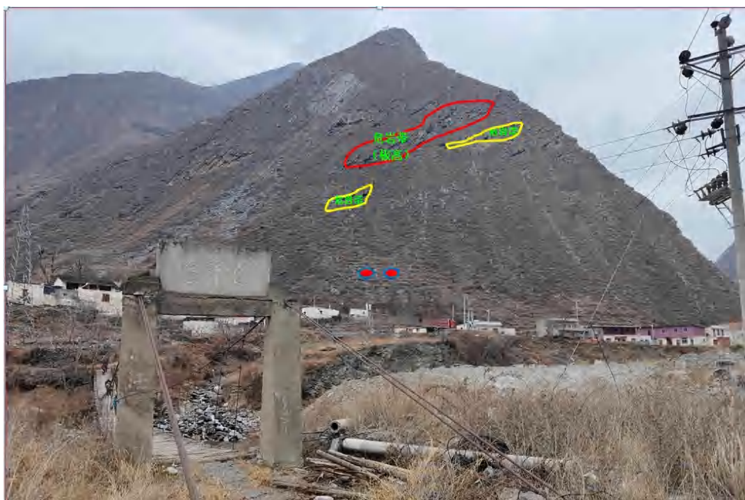
2.4-15 B 线石大关隧道出口地形地貌与不良地质照片
