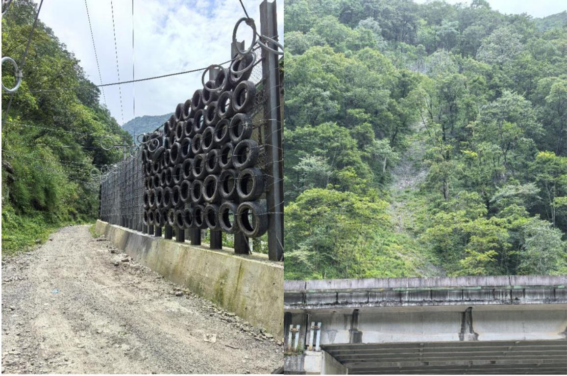
格栅型被动防护网（左图）和主动防护网（右图中间沟槽）
