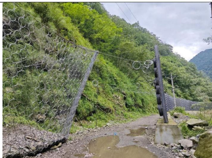
图 2-24 施工完成后的被动网
