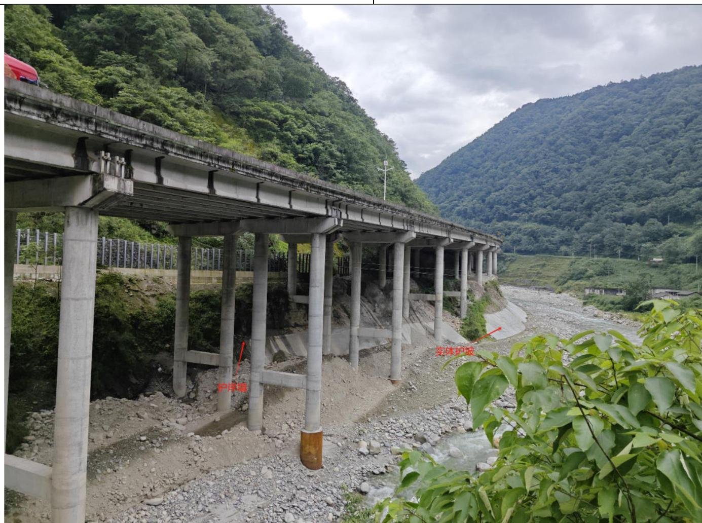
图 2-26 施工完成后的护岸墙及实体护坡
