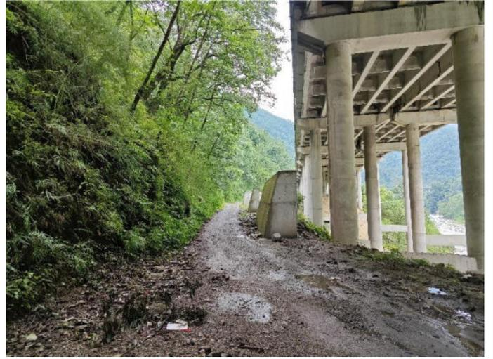
图 2-28 施工完成的挡石墙
