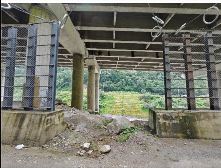
图 2-27 施工完成后的型钢格栅
