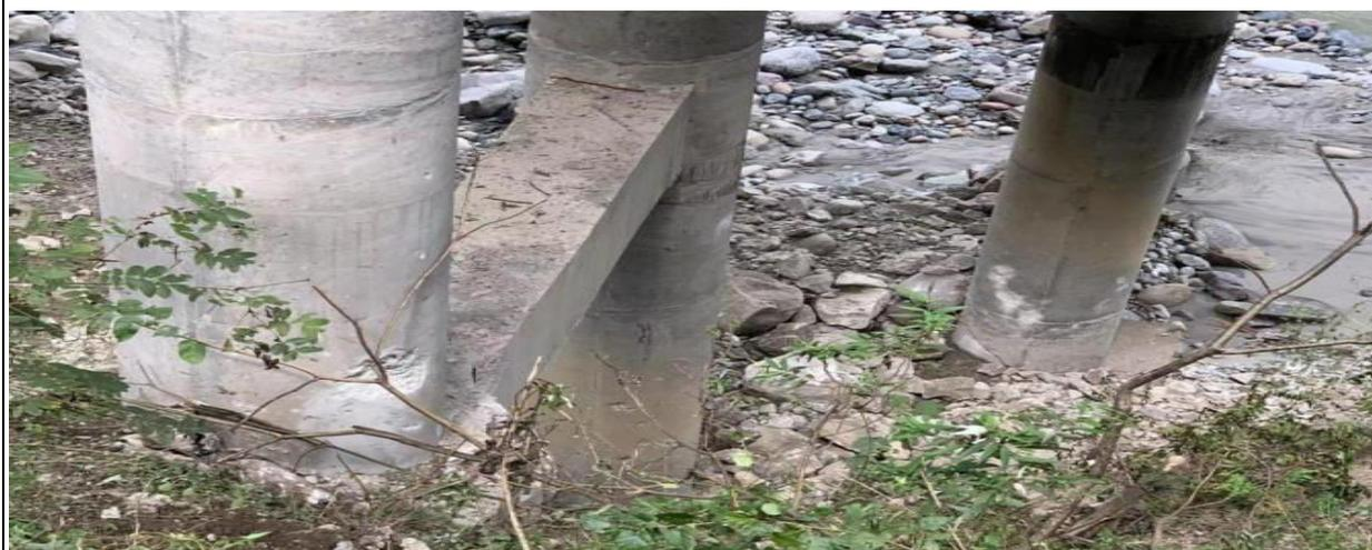
图 2-13 桥梁下部结构桥墩受落石撞击
