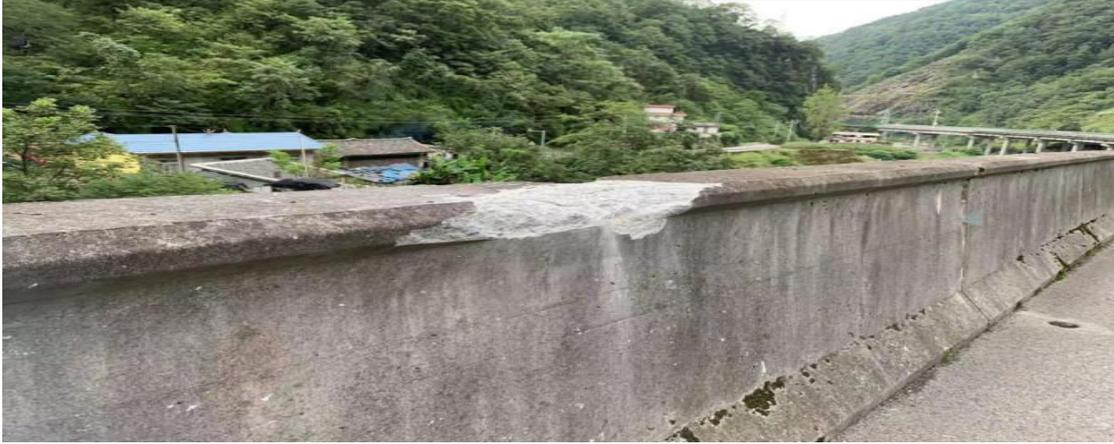
图 2-14 桥梁上部结构护栏受落石撞击
