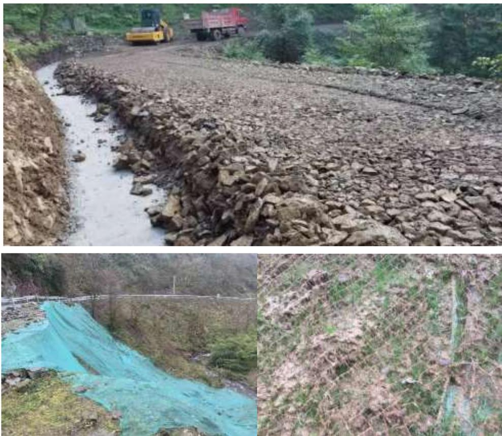
图 2.2 乐西高速马边至昭觉段 S1-8 项目施工便道水土保持措施
