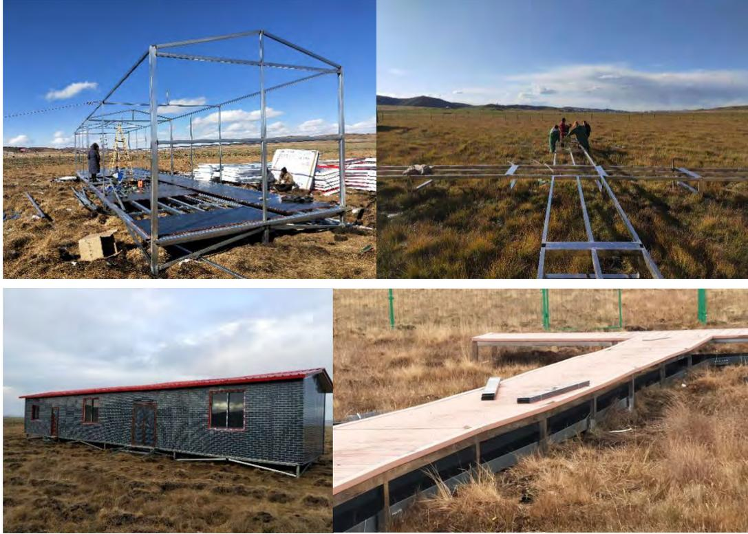
图 2.3 板房与栈道钢结构图
